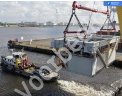
De draagpunten van het bouwhekwerk zijn nu klaar en worden nu met een kraan opgehoofd.
