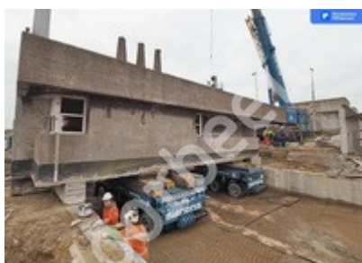
Het wachhuis van de IJmuidensluis op de aanbesteding stond in de weg en moest zes weken later worden geroofd. Om de grond te bevestigen is ook het wachhuis op de aanbesteding verwijderd. Hiervoor werden hydraulische heftrucks onder de knieën aangetrokken.
